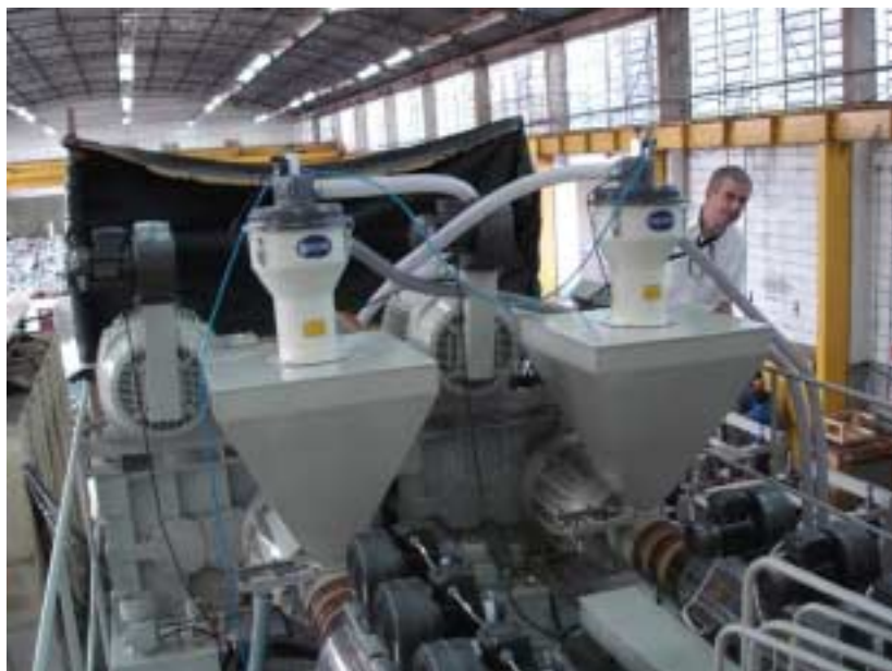
Figura 4.9 - Vista dos alimentadores da sopradora HDL-30.
